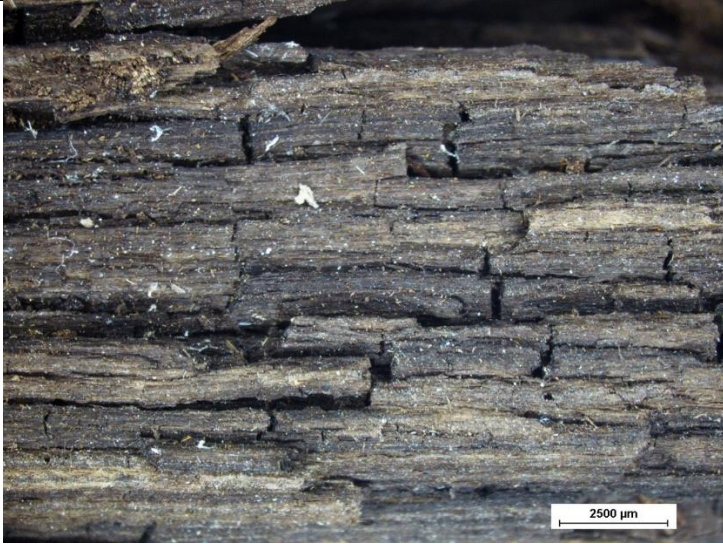
Foto 4: Holz dunkel verfärbt, Würfelbruch vorhanden; Würfelbruchlänge etwa 2 ... 6 mm; M 7,5:1
